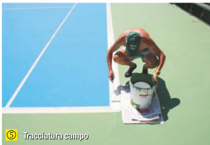
Lavori in corso ASD Granarolo
